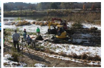
ユンボによる除去作業
