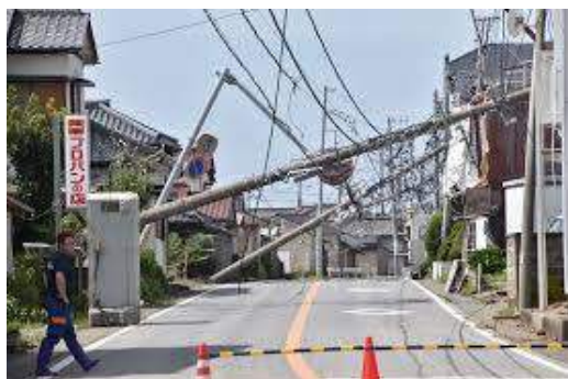
←道路を塞ぐ 電柱
